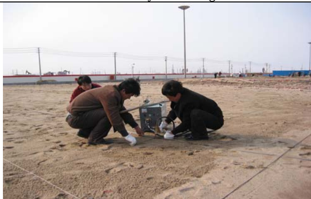
储罐阴极保护网状阳极系统安装 MMO Grid System for Tank Bottom CP
