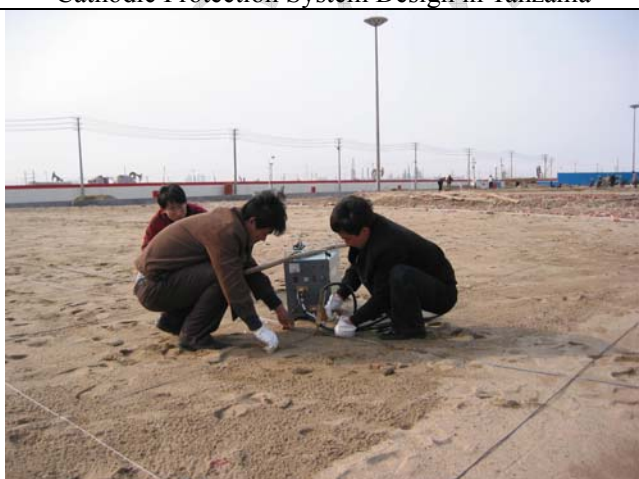
储罐阴极保护网状阳极系统安装 MMO Grid System for Tank Bottom CP
